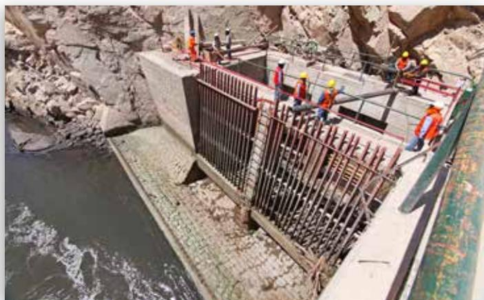
En 2014, dans le cadre des travaux à Cerro Verde pour améliorer l'infrastructure hydraulique dans la région d'Arequipa, la reconstruction d'écluses du Rio Chili a été achevée. Les nouvelles écluses ont remplacé les infrastructures vétustes et ont aidé à maintenir l'intégrité des systèmes d'irrigation agricoles régionaux au cours de fortes précipitations.
