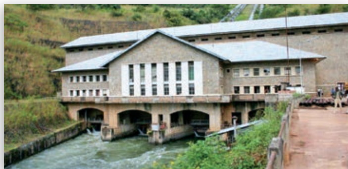
TFM a investi plus de 215 millions $ pour rénover cette centrale hydro-électrique en RDC, notamment pour la rénovation des quatre turbines. Cet investissement fournit une électricité renouvelable plus fiable pour la région et pour les opérations de TFM.
