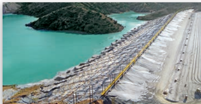
Le barrage de retenue de résidus Upper Mammoth à Bagdad, en Arizona, est une extension du barrage d'origine construit en 1985. Le barrage, construit selon la méthode dite centrale, n'atteindra pas sa capacité maximale de stockage des résidus avant 18 ans.
