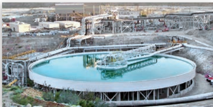
En 2013, la mine de Bagdad en Arizona a achevé la construction du plus grand et plus élevé bassin de rejets épaisseur (décanteur) au monde. L'épaisseur permettra l'augmentation des volumes d'eau à récupérer, ainsi que la réduction des pertes par évaporation et par infiltration du dispositif de stockage des résidus.
