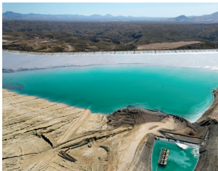
La mayor parte de nuestra agua reciclada proviene de aguas recuperadas captadas en tranques de relaves y canchas de lixiviación. En la foto, agua en el depósito de relaves de Morenci (Estados Unidos) lista para ser reciclada.
