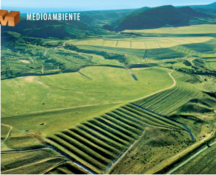
Recuperamos tranques de relaves inactivos nivelando taludes, transportando y desviando las aguas pluviales, colocando recubrimiento y resembrando con pastos y arbustos nativos. En la foto, TSF de Tyrone, Nuevo México, después de la recuperación
