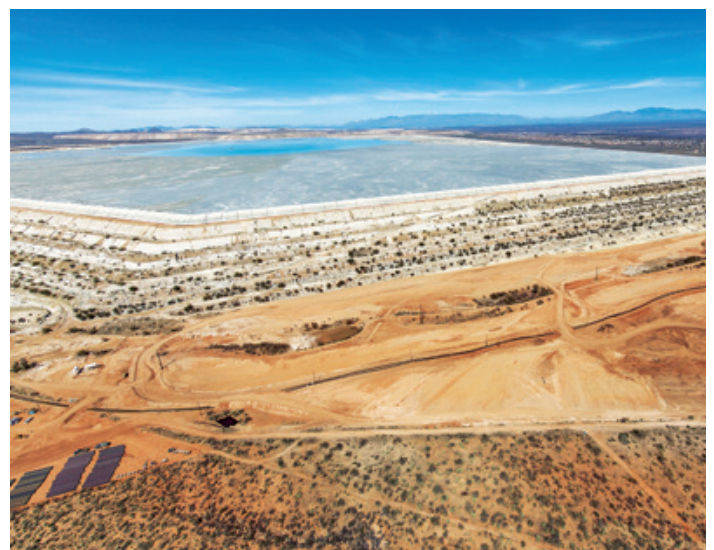
Los tranques de relaves activos son monitoreados continuamente, verificando la estabilidad estructural del dique del terraplén y aspectos ambientales tales como el potencial de generación de polvo. En la foto, la construcción del contrafuerte brinda estabilidad adicional al TSF de Sierrita cerca de Green Valley, Arizona.
