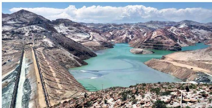
El nuevo depósito de relaves de Linga (arriba) y el depósito de relaves Enlozada en Cerro Verde son dos de los depósitos de relave más grandes en el sector minero a nivel global. Ambos fueron diseñados y construidos para soportar un terremoto de hasta magnitud 9.0 y una Máxima Inundación Probable.
