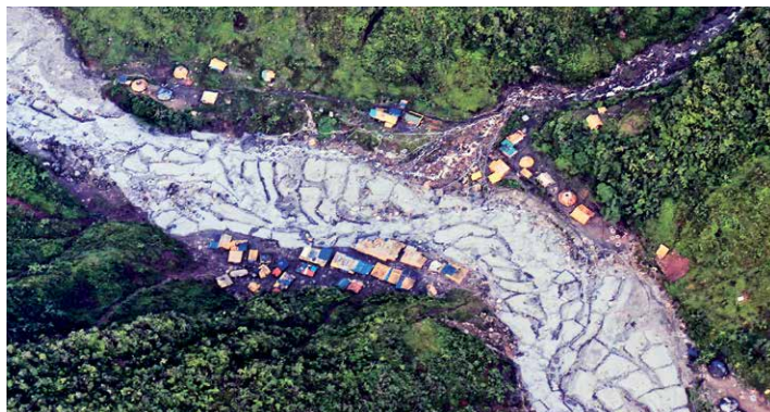
Vista aérea de las terrazas del dique y los campamentos de lavadores en la parte montañosa del área del proyecto de PTFI.
