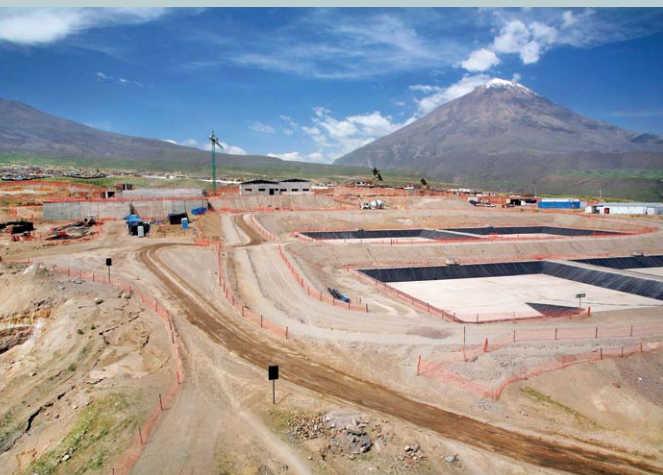
Construcción de la nueva planta de tratamiento de agua de la ciudad de Arequipa. Se espera brinde suministro a un millón de personas a inicios del 2012.
