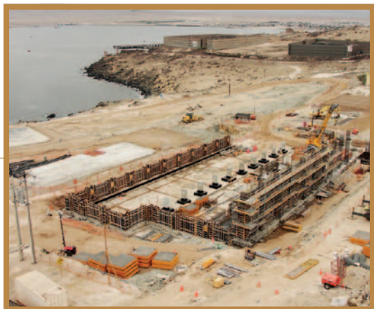
Notre opération de Candelaria au Chili élargit ses sources d'approvisionnement en eau en raison de l'épuisement rapide de l'aquifère du fleuve Copiapó. Photo : Freeport-McMoRan investit environ 300 millions de dollars pour construire une usine de dessalement près de l'océan Pacifique et un pipeline vers son lieu d'opération. La construction devrait être achevée au début de 2013 et, une fois en service, l'usine de dessalement pourvoira aux besoins d'approvisionnement en eau à long terme de Candelaria.
