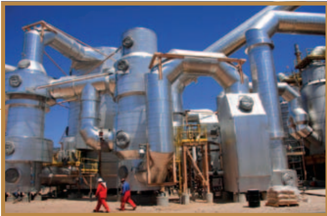
Foto: Durante 2011, completamos la construcción de un quemador de sulfuro en Safford. La planta proporciona una fuente de ácido sulfúrico más económica que las que se utilizan en las operaciones de lixiviación de cobre, y tiene como consecuencia costos de transporte más bajos. La planta no sólo produce ácido sulfúrico sino que el calor creado en el proceso se usa para producir vapor de alta presión que activa una turbina para generar 15 megavatios de electricidad. La planta y las instalaciones de procesamiento, incluida la nave de electro-obtención, utilizan la electricidad y ahorran a la compañía cerca de US$5,7 millones anuales en costos de energía.
