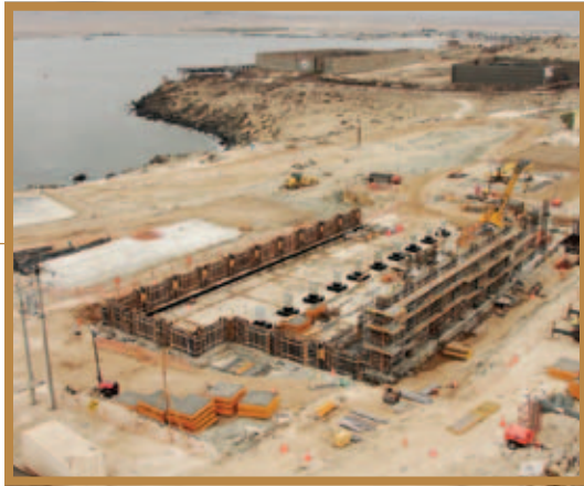
Nuestra operación de Candelaria en Chile actualmente amplía las fuentes de suministro hídrico debido al reciente agotamiento rápido de la capa freática del río Copiapó. Foto: Freeport-McMoRan actualmente invierte aproximadamente US$ 300 millones en la construcción de una planta de desalinización cerca del Océano Pacífico y de su traslado hasta la operación. Se espera que la construcción finalice a principios de 2013 y una vez en funcionamiento, la planta de desalinización suministrará agua a Candelaria durante mucho tiempo.
